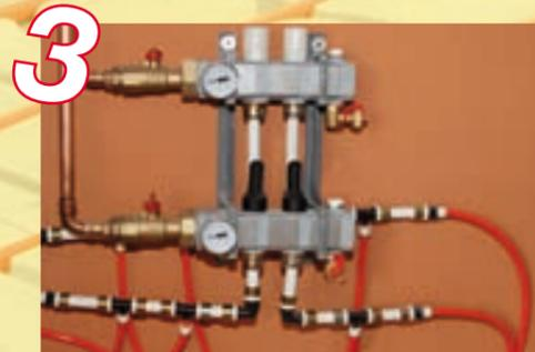
**A**CTIFLOOR è un sistema di riscaldamento ad acqua adatto a pavimenti e pareti. La brevissima distanza tra il tubo posato e il piano di capestio assicura un'irraggiamento uniforme del calore.
